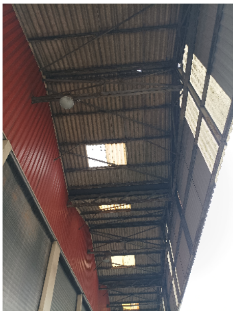
I0001 - Plaques fibrociment auvent Equipements extérieurs RDC, QUAI Présence d'amiante
