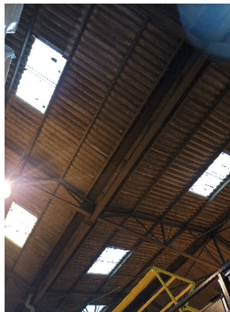
I0002 - Plaques (fibres-ciment) Equipements extérieurs Toiture, Toiture Présence d'amiante
